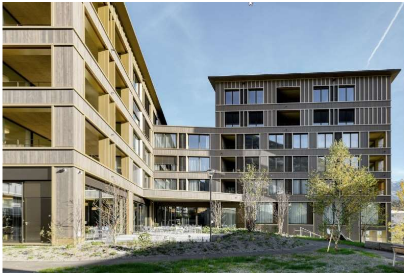
Referenzprojekt – Alterszentrum Allmendpark, Alpnach
